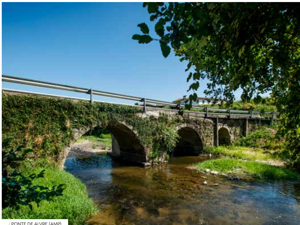
/ PONTE DE ALVRE (AMP)
