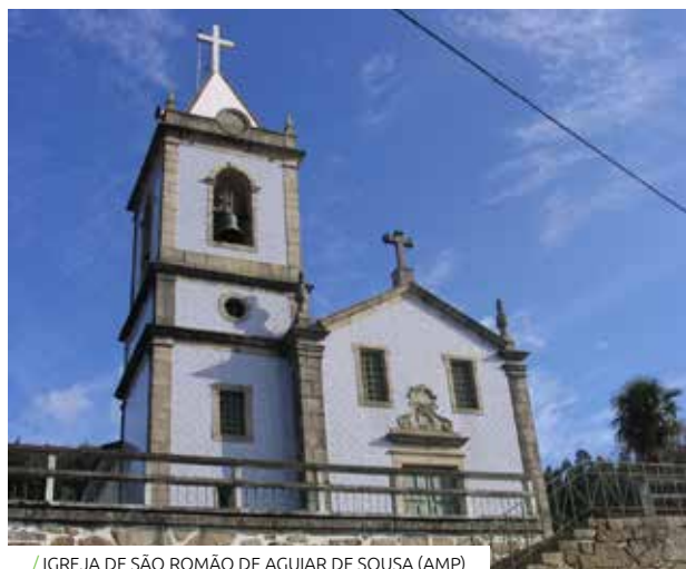
/ IGREJA DE SÃO ROMÃO DE AGUIAR DE SOUSA (AMP)
