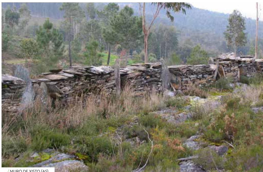
/ MURO DE XISTO (AS)
