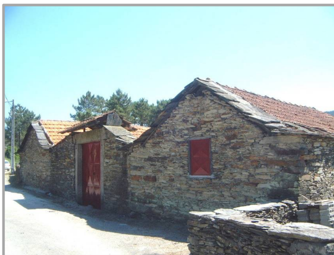
Construção Aguiar de Sousa
