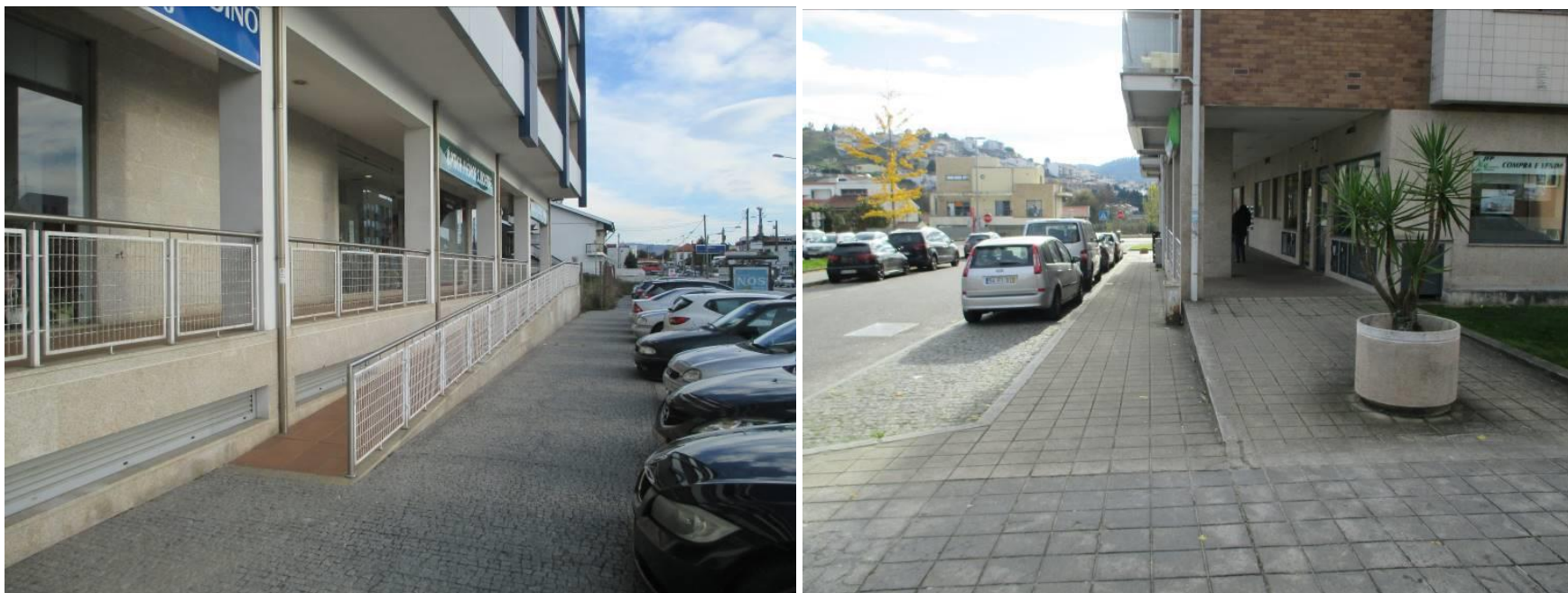
Figura 39. Maus exemplos associados à incorreta colocação de Degraus e Escadas no município de Valongo
