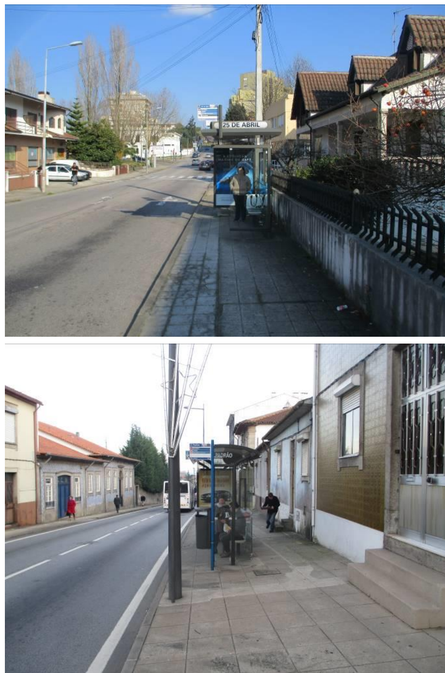
Figura 86. Necessidade de colocação Sinalização de paragens reservadas a autocarros (H20a)
