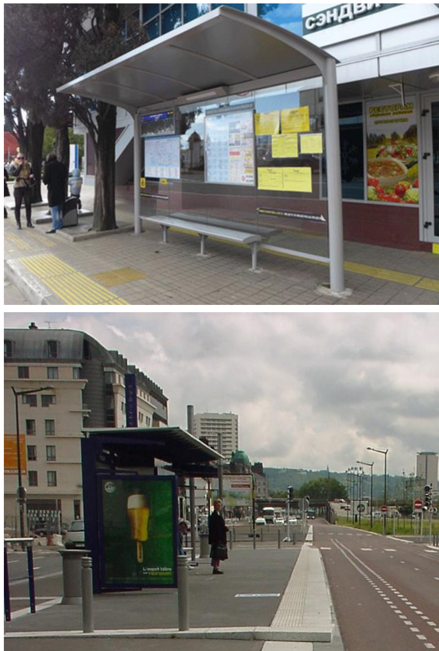
Figura 87. Exemplo de abrigos com pavimentos táteis e direcionais
