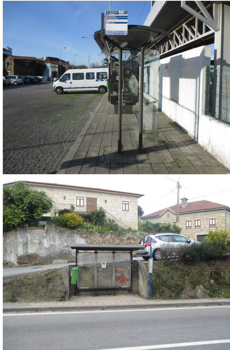
Figura 84. Necessidade de alteração do design dos abrigos
