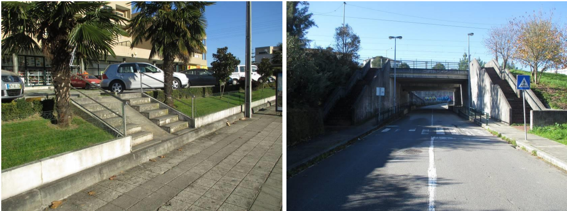
Figura 37. Maus exemplos associados à incorreta colocação de Degraus e Escadas no município de Valongo
