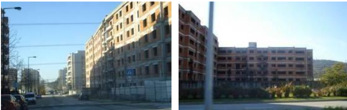
Figura 4. 4 Estruturas inacabadas de edifícios plurifamiliares
