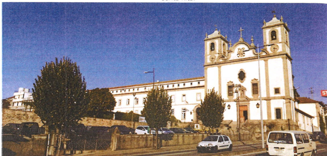
Fig. 2. Convento da Formiga e Igreja de Nossa Senhora do Bom Despacho da Mão Poderosa e de Santa Rita.
