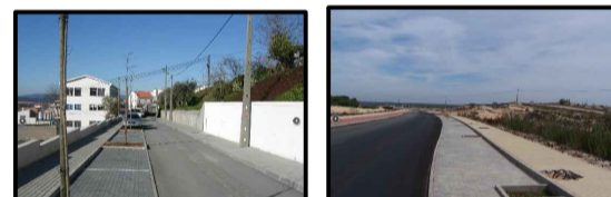
Estacionamento em espinha em pavimento de Pavet Cinzento da Artebel modelo Holanda com guias de betão a delimitar lugares
