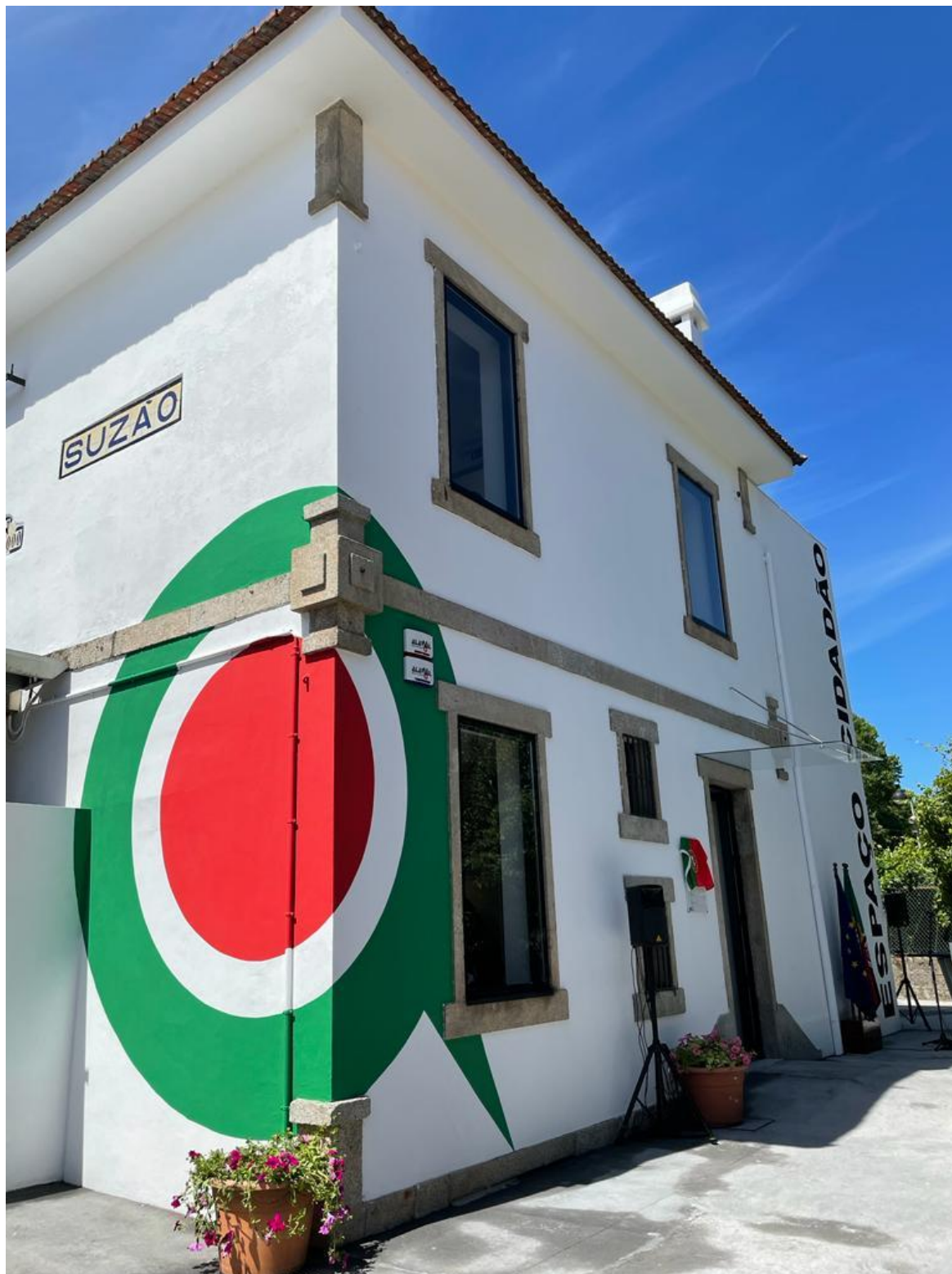
Fotos após a intervenção
