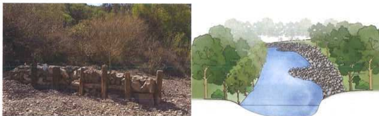
Figura 22 – Defletor de corrente (fotografia e alçado)
