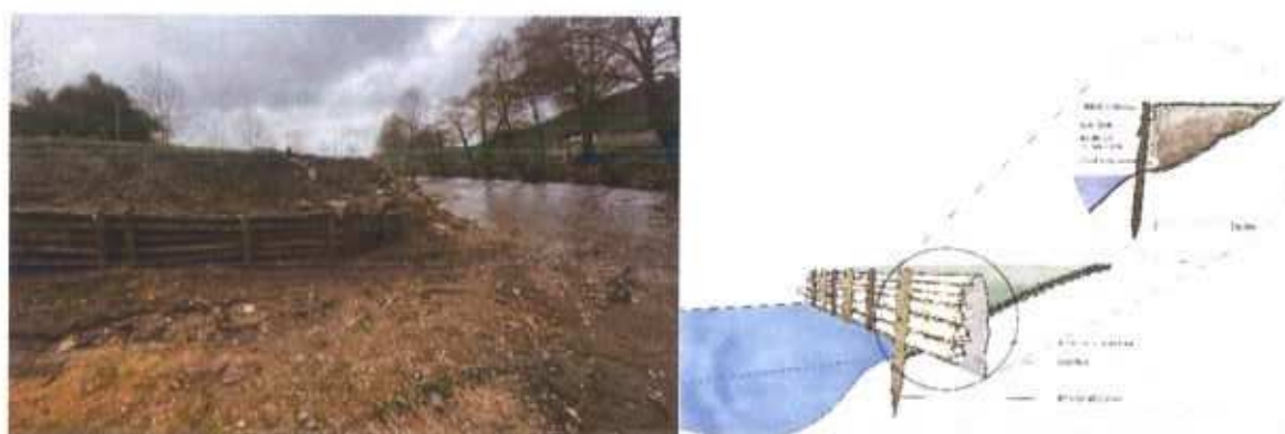
Figura 14 – Paliçada viva (fotografia, secção transversal e alçado)
