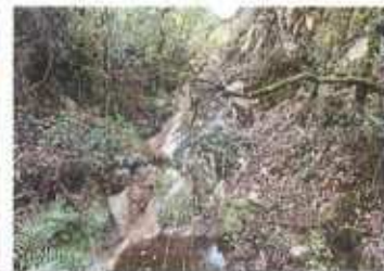
Aspeto geral do troço fluvial
