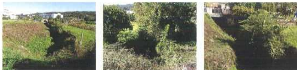
E1_V1P4 (41°11'22.55"N, 8°29'24.07"W), RIBEIRA PONTE DA PRESA, RUA ILHAR MOURISCO
