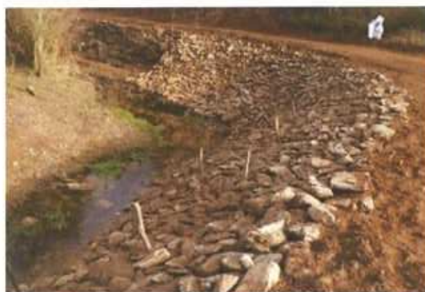
Figura 19 – Enrocamento vivo (fotografia, secção transversal e alçado)
