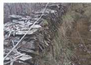
Margem direita regularizada com muretes de xisto
