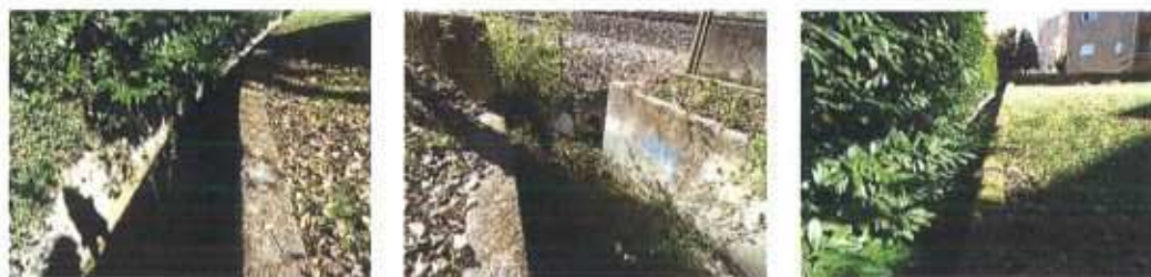
E1_V1P5 (41°11'41.74"N, 8°29'45.80"W), RIBEIRA PONTE DA PRESA, RUA ANTÓNIO RODRIGUES VALE
