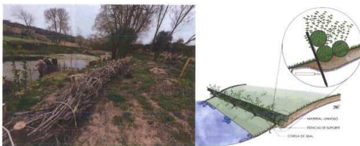
Figura 16 – Faxina viva (fotografia, secção transversal e alçado).
