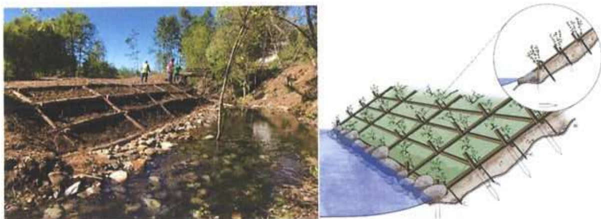
Figura 17 - Grade viva (fotografia, secção transversal e alçado)
