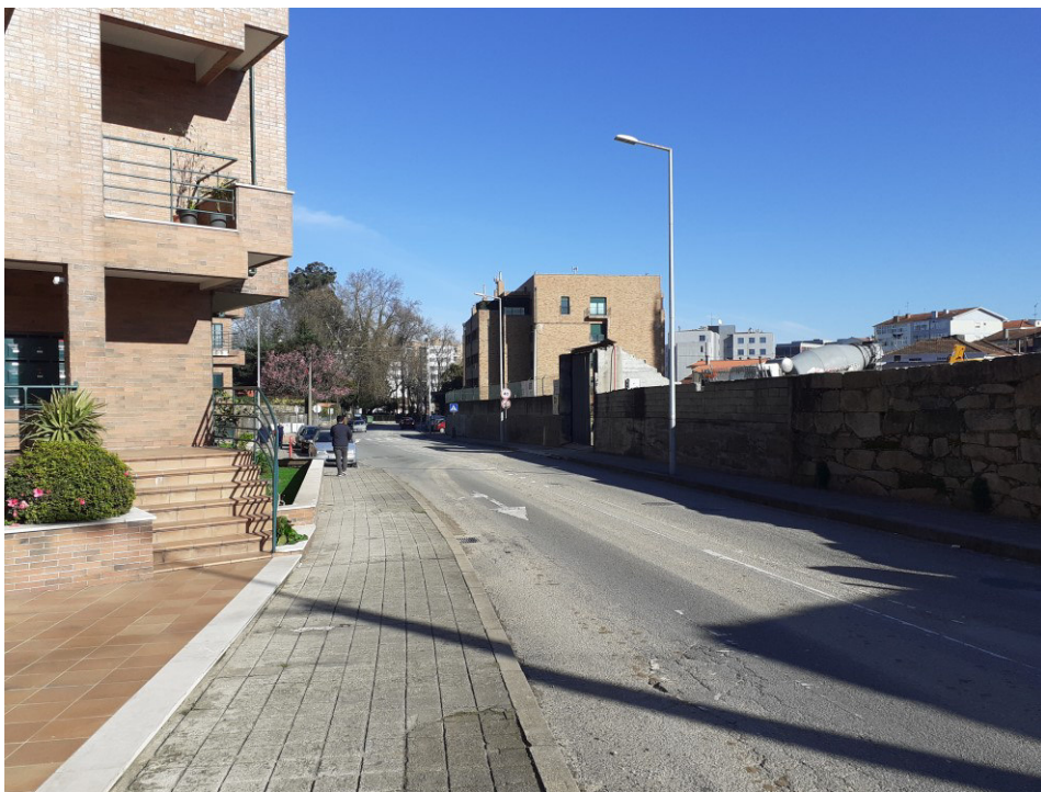
Imagem 1: Localização da zona de intervenção para abertura de valas e colocação de tubagem para execução das ligações às caixas existentes na via pública.
